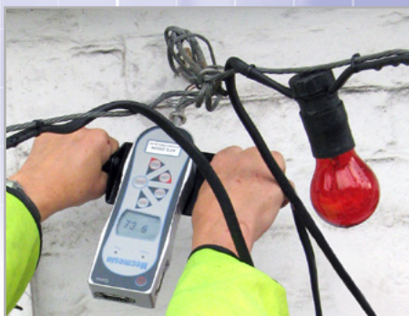
Essai de traction sur points d'ancrage
